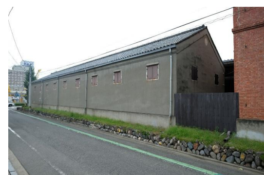
江原本家上毛倉庫一号棟
