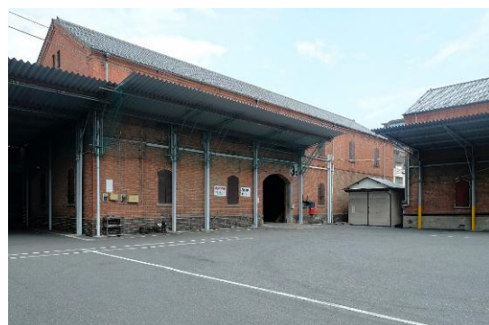
江原本家上毛倉庫三号煉瓦棟
